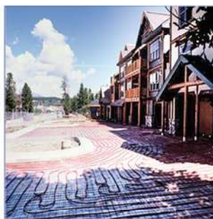
پایاده روها و رمپ ها جهت ذوب برف و یخ
